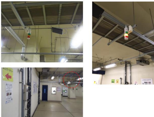
↑天井据え付け型アンテナ及びパトライト
